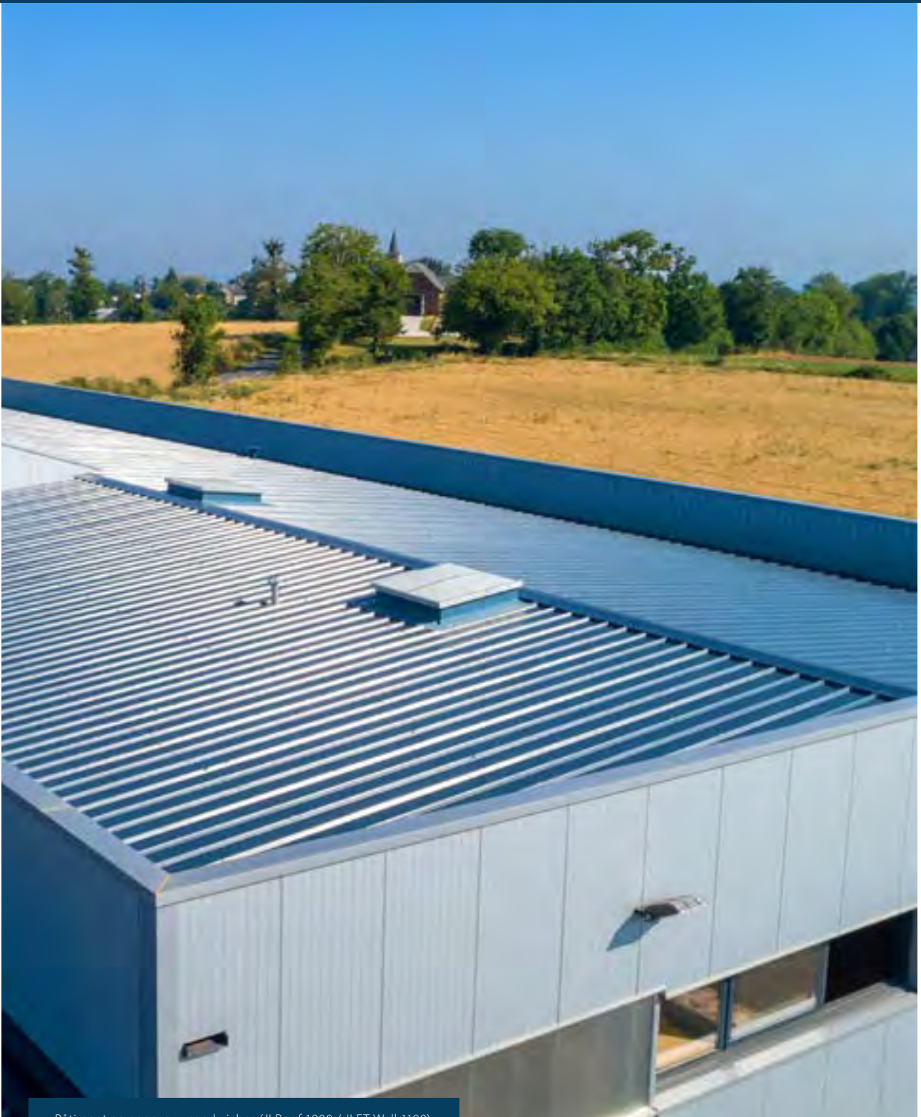
Bâtiment en panneaux sandwichs (JI Roof 1000 / JI FT Wall 1100).
